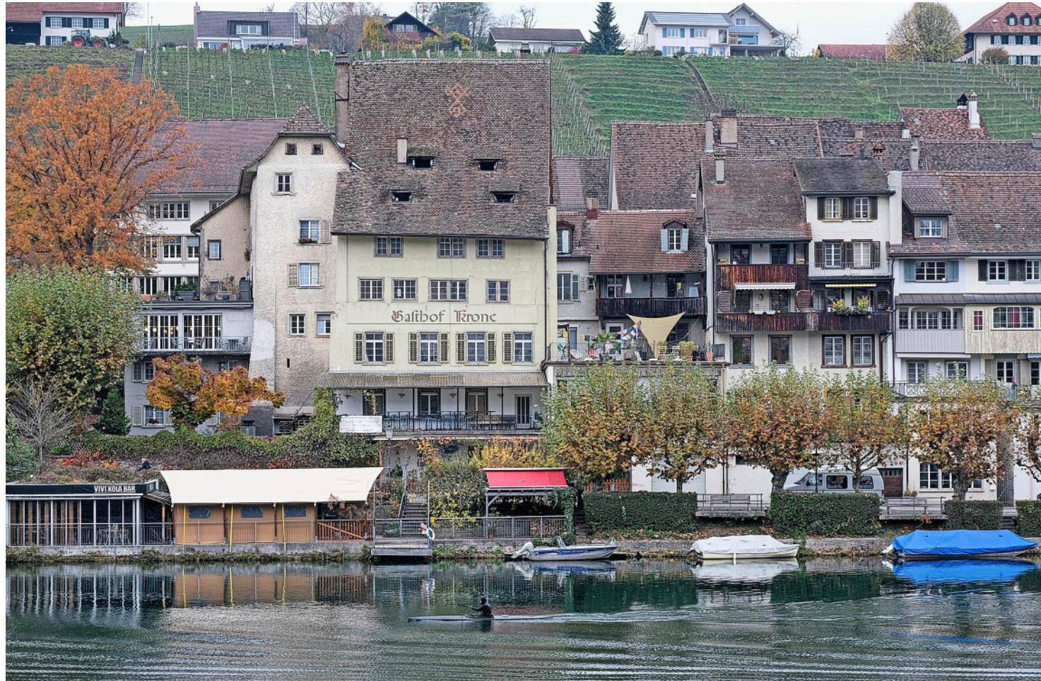
Das denkmalgeschützte Krone-Gebäude am Rhein hat neue Besitzer und soll für 20 Millionen Franken renoviert werden. Foto: Leo Wyden
